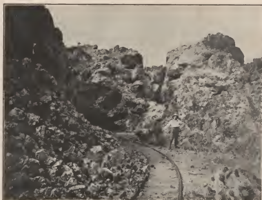
168. INGANG VAN EEN ONDERZOEKINGSTUNNEL VAN DE PHOSPHAATMIJN SANTA BARBARA
